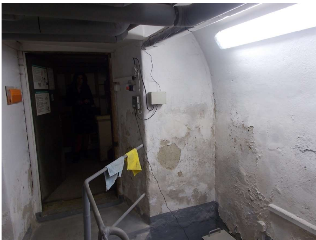
Obrázek č.19 – Vzlínající vlhkost 1.PP
