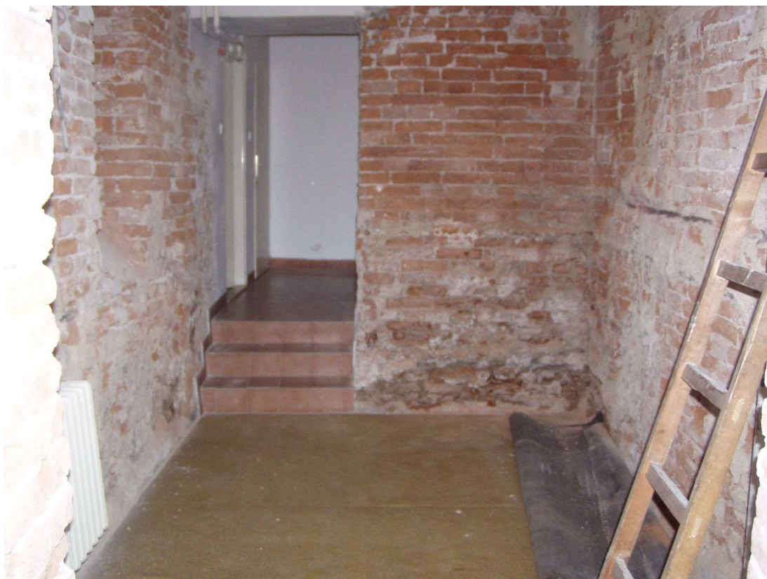
Obrázek č.5 – Porušení omítek vlhkostí – chodba 1.NP
