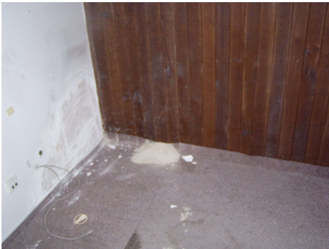
Obrázek č.2 - Stav v 1.PP – vlhké zdi a obklad
