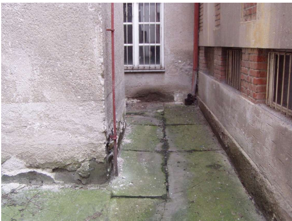
Obrázek č.21- Vzlínající vlhkost – dvůr
