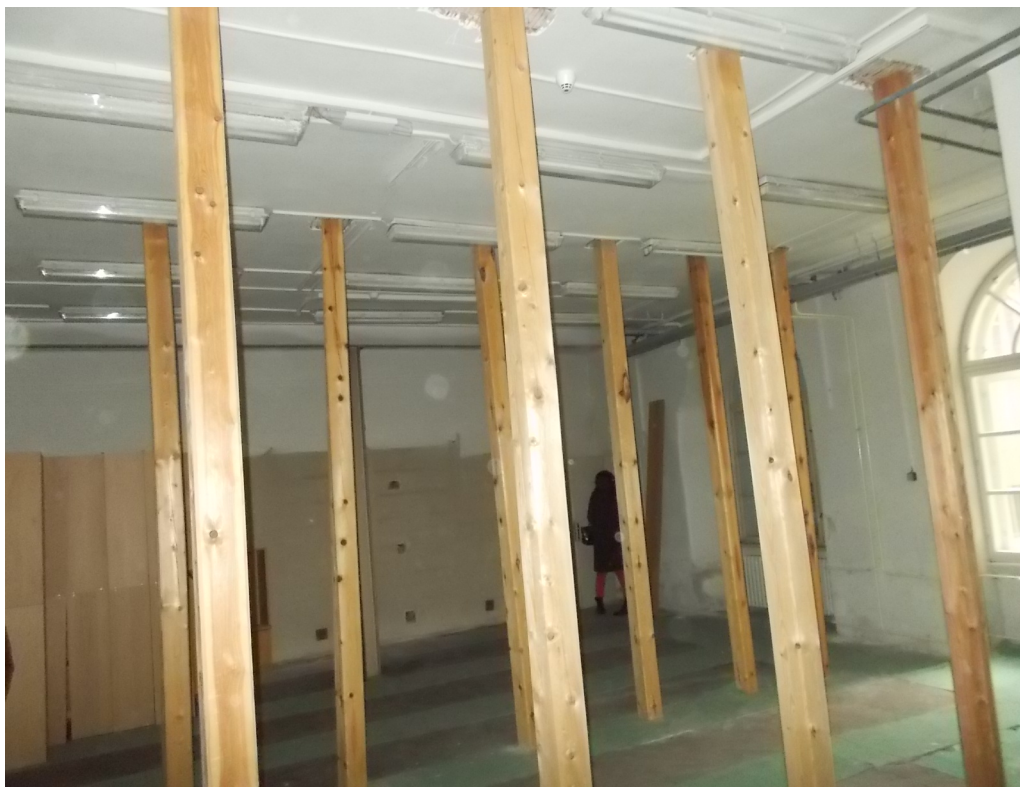
Obr. 2 - Prostor v 1. NP s podepřením stropu a s kopanou sondou k základům
