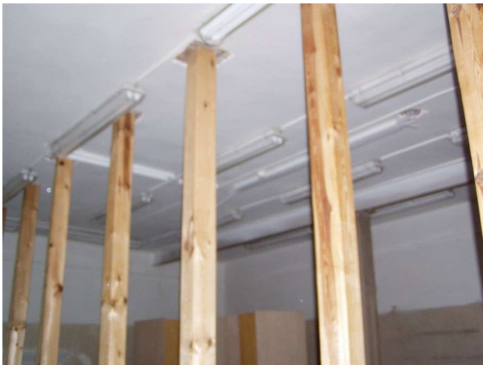
Obrázek č.7 – Přetížený strop v místnosti 1.13. 1.NP
