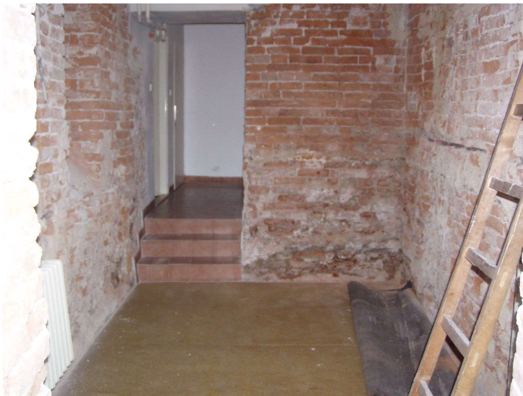
Obrázek č.9 – Porušení omítek vlhkostí – chodba 1.NP
