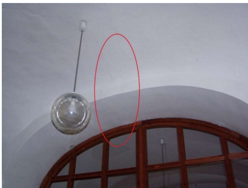
Obrázek č.23 – Porušení omítky v klenbě
