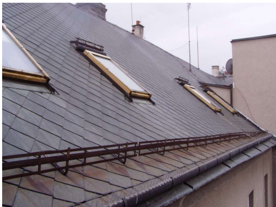
Obrázek č.11-: Měděná střecha – šablony
