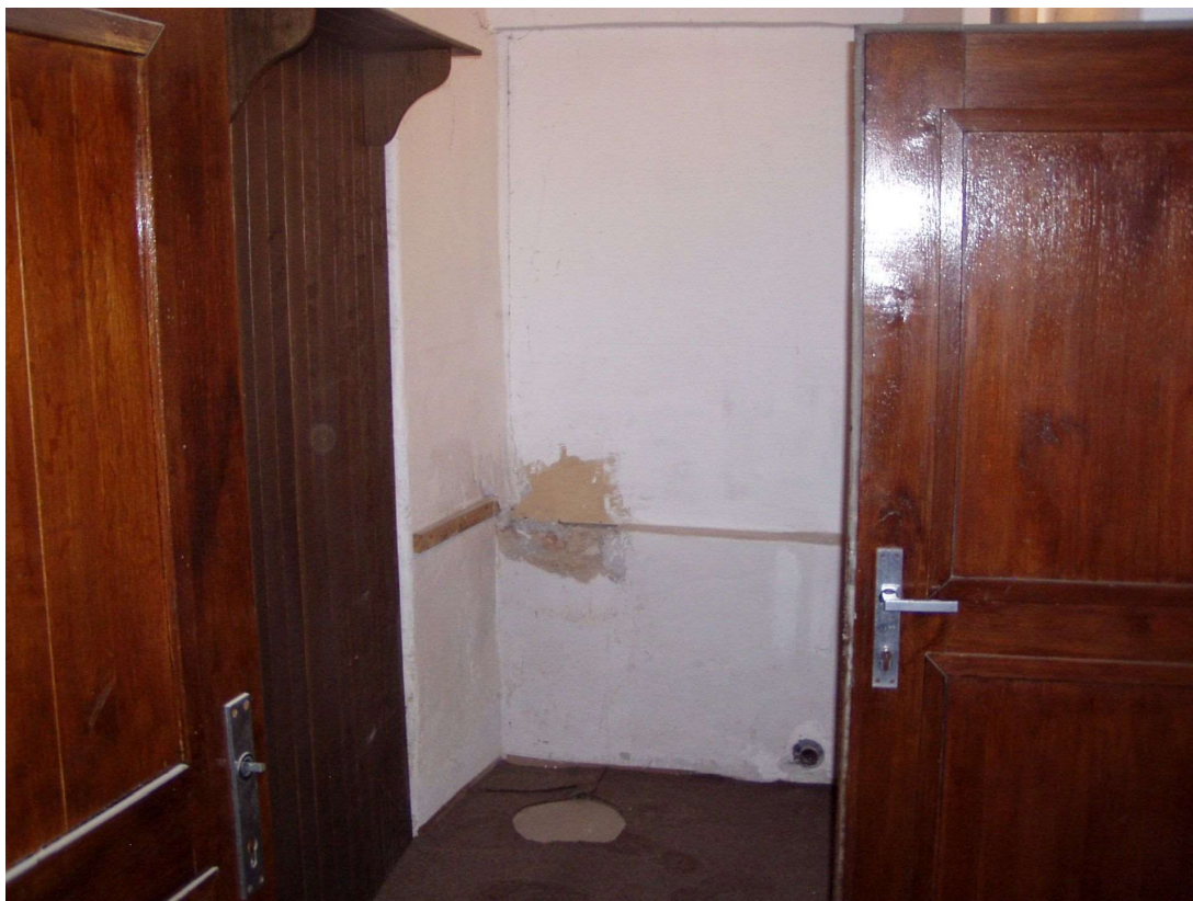
Obrázek č.1–1.PP-poškození zdi vlhkostí
